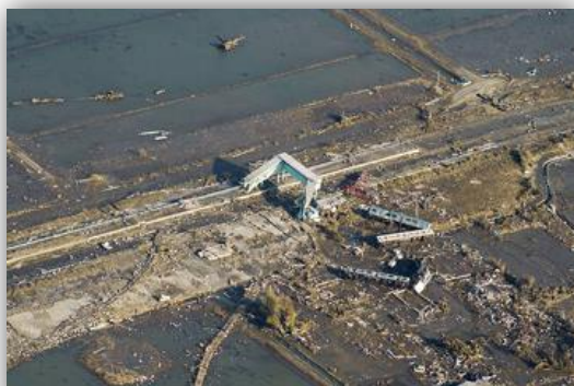
津波を受けた福島県新地町のJR新地駅（2011年3月15日）
